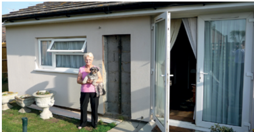
Behind Mrs Bunce, resident in Rushenden, the opening in the wall awaits the installation of the glass frame, which will cover the block work to be painted black. Derrière Mme Bunce, locataire à Rushenden, une ouverture a été découpée. Elle sera couverte par un cadre vitré et la masse thermique en béton sera peinte en noir.
