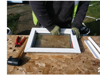
1. A Prima fitter at work. The renovation of all the windows of one house takes one day. Un ouvrier de Prima au travail. La rénovation de toutes les fenêtres d'une maison prend une journée. 2. Glass units are only replaced if defective. Les vitrages ne sont remplacés que s'ils sont défectueux.
