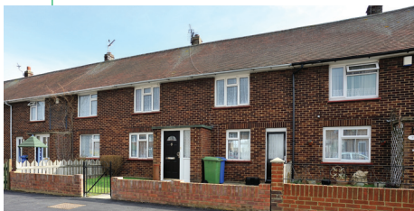
Maisons à Rushenden avant les travaux. Première étape de la validation, la collecte des données de températures réelles dans les maisons, réalisée depuis novembre 2011. Houses in Rushenden before the works. As a first step of validation, the indoor environments of the houses were investigated since November 2011.
