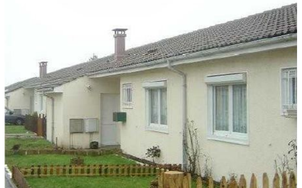
Maisons à Rushenden, sur l'île de Sheppey, dans le Kent (à gauche) et à Outreau (Pas-de-Calais). à droite.
